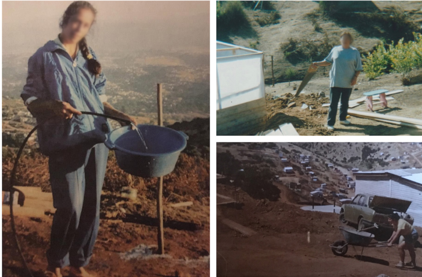
FIGURA 2 | Mujeres en la autoconstrucción de asentamientos informales en la ciudad de Viña del Mar. Fotografías de pobladoras del campamento Manuel Bustos desempeñando un rol activo en la conformación de viviendas y en la gestión urbana del territorio.
