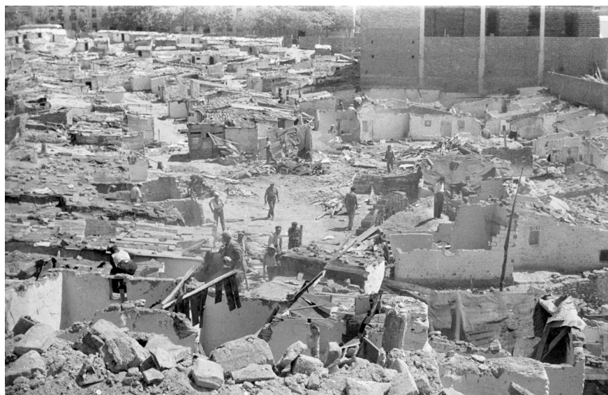
FIGURA 3 | Demolición de la barriada de chabolas Jaime el Conquistador, 1957
